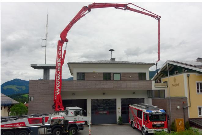
Am Feuerwehrhaus wird eine neue Attika betoniert.
